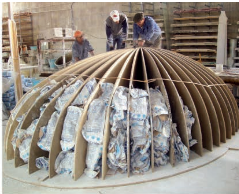
Realizzazione di una cupola ovale ellittica / Creation of an elliptical oval dome
